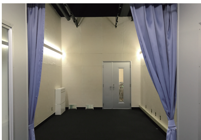
200kV TEM 設置室
