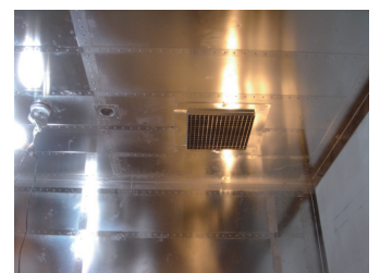
磁気シールド工事施工例
