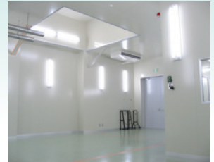
クリーンルーム
