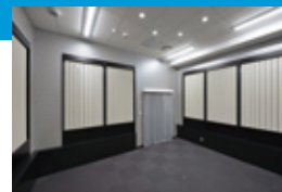
輻射空調設置室
