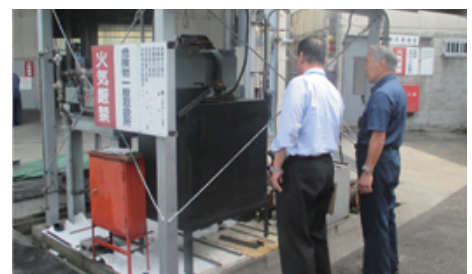
— 廃棄物処理施設の現地確認 —
