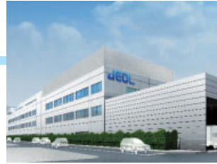
本社・昭島工場3号館 (クリーンルーム増設)
