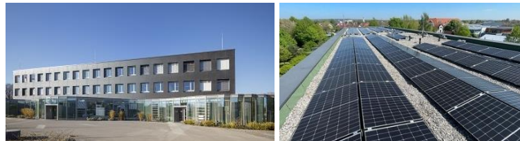
JEOL(GERMANY)GmbH建物屋上に設置した太陽光発電パネル
