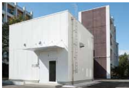
800 MHz NMR 装置が設置されている建屋
