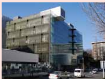
化学測定機器室のある物質科学国際研究センター
