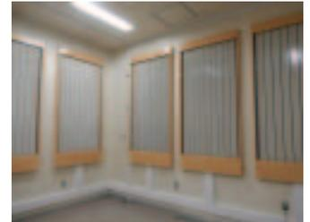
専用の高精度チラーより、設置室壁面に設置された輻射冷却パネルへ安定した温度の冷却水を供給し、装置より発生する熱を除去します。輻射冷却パネル本体には、アルミ押出成形材を使用し、冷却に必要な面積を確保するとともに意匠にも優れます。
