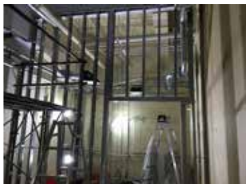
間仕切り工事
