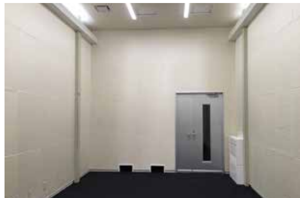
グラスウール吸音板施工例
