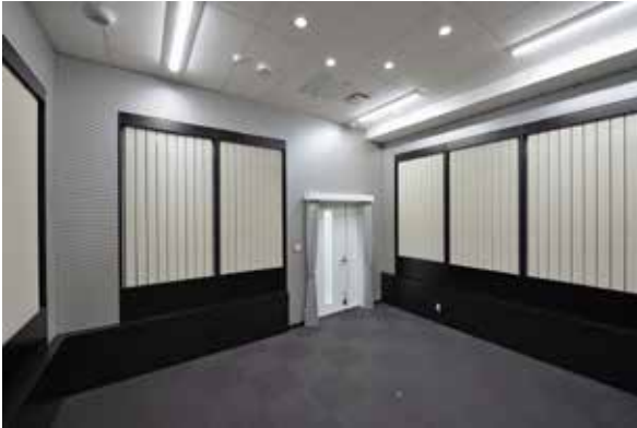
水冷輻射パネル施工例
