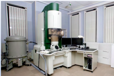
透過電子顕微鏡設置室 輻射パネル
