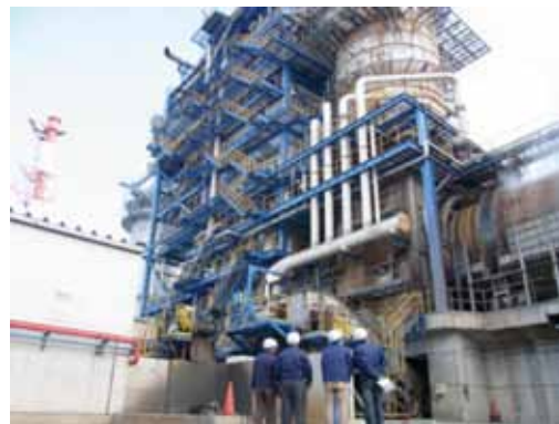
廃棄物処理施設の現地確認（2）
